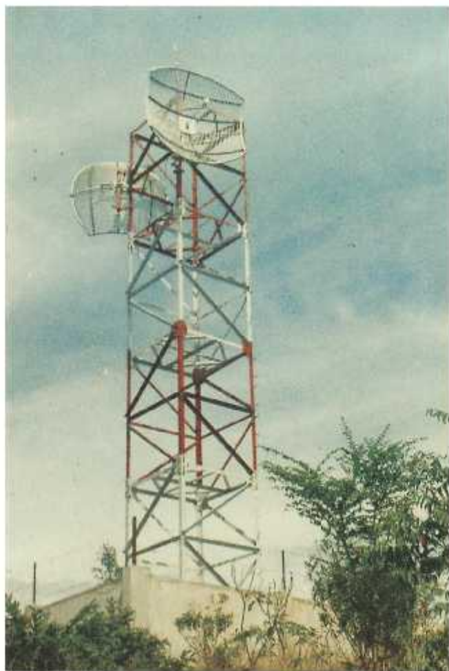
Trạm vi ba Bưu điện huyện Sơn Tây đặt trên núi Tà Mực cao 882m so với mặt biển
