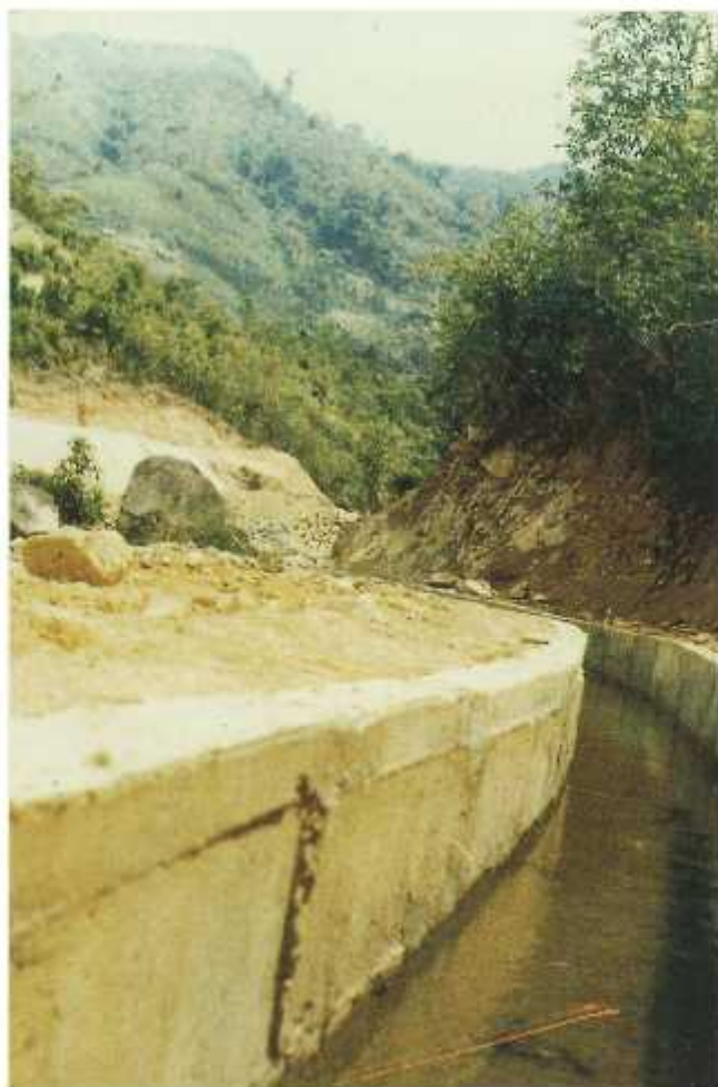
Kênh mương bằng bê tông Đập nước Min - xã Sơn Mùa
