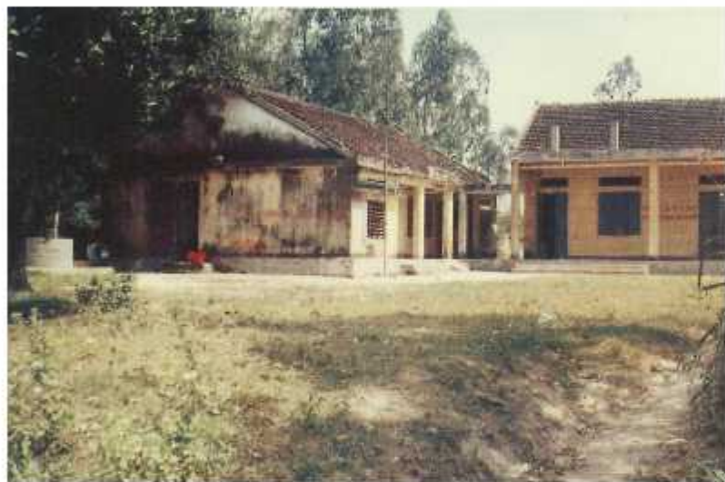
Trạm y tế xã Tinh Bình
