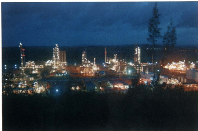
Nhà máy lọc dầu Dung Quất.
