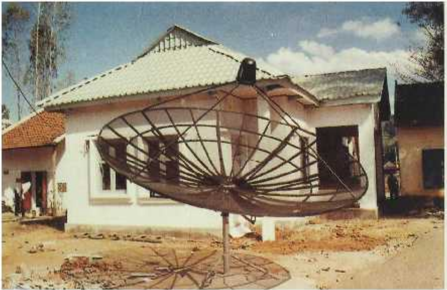
Trạm thu phát sóng truyền hình cụm xa Ba Vì vừa được lắp đặt Ảnh: THANH LONG
