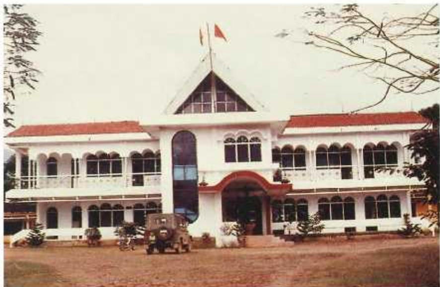
Trụ sở Huyện ủy Ba To vừa được xây dựng Ảnh: LH
